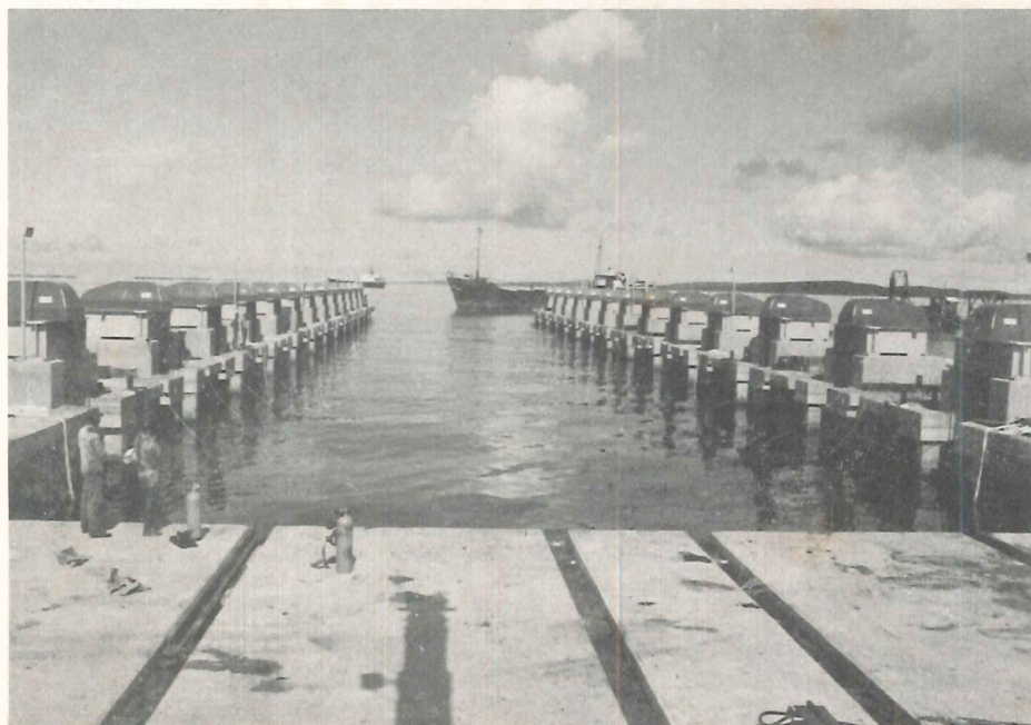
La foto muestra la colocación y distribución de los 28 Winches. Al fondo un buque se apresta a entrar al sincroelevador.
